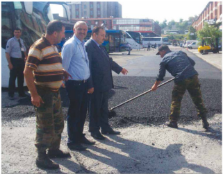
Dolapdere San. Sit. Bşk. Cemal Bacako sitedeki asfalt çalışmalarını takip ederken...
